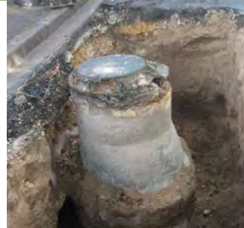
Travaux Rue de Tours
